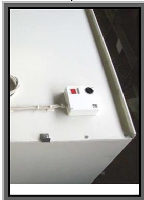
Interruttore e regolatore di velocità per ventilatore di espulsione supplementare, posizionati sul tetto della cappa.
