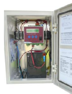
Montaggio nel quadro IP65 per esterni
