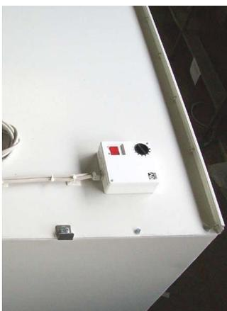
Interruttore e regolatore di velocità per ventilatore di espulsione supplementare, posizionati sul tetto della cappa.
