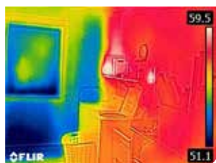
Parete esterna non isolata
