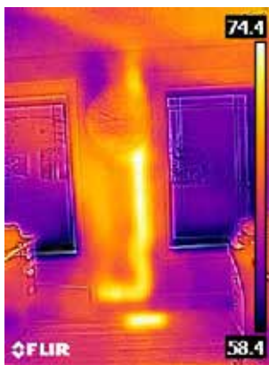
Tubo di scarico caldo nella parete
